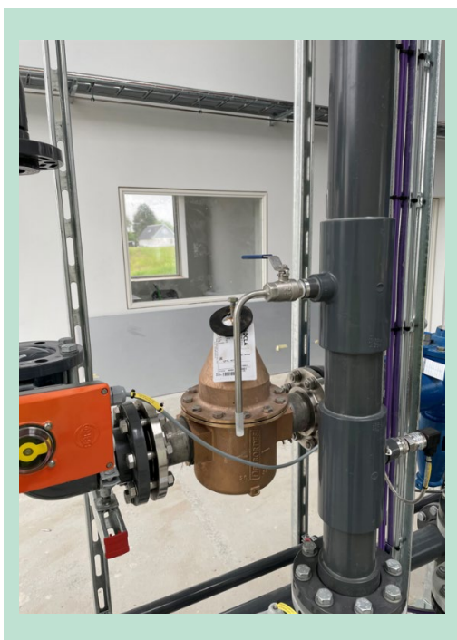
FIGUR 4.11. Billede af tilbageløbssikringsventilen.
