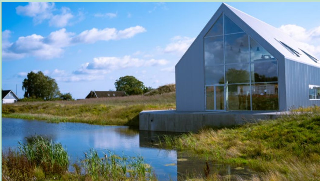
FIGUR 4.2. Renseværket er tegnet af LOOP Architects og er tilpasset ind i den overordnede designløsning for boligerne i Nye. Renseværket fremstår stilrent og inviterende til omgivelserne med vinduespartierne, der åbner op for at se ind til det tekniske vandbehandlingsanlæg.
