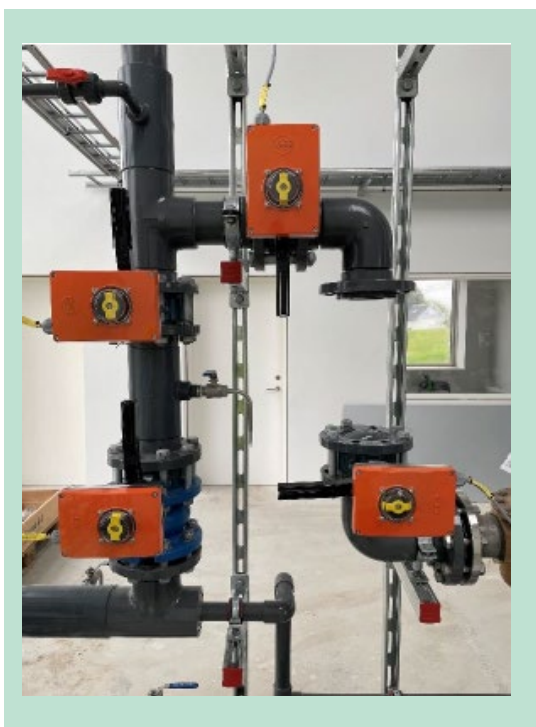
FIGUR 4.10. Billede af passtykket til fuld omkobling til drikkevand.
