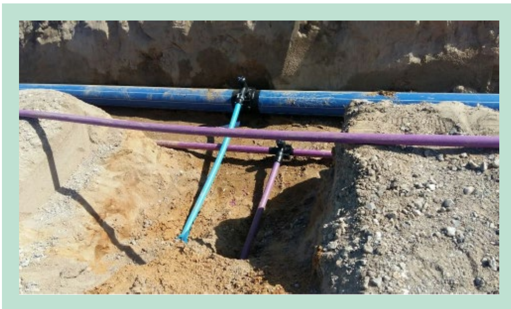
FIGUR 5.3. De to ledningstyper i distributionsnettet.
